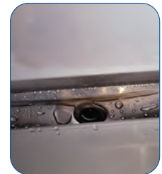
Cuentan con desagüe en el interior de la cámara.
